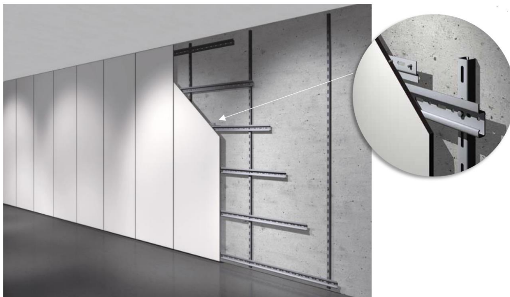
26 paveikslas. Nematomas kompaktinio laminato tvirtinimas
